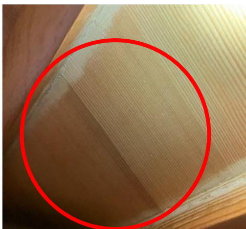
響板の亀裂（雑音の原因）
